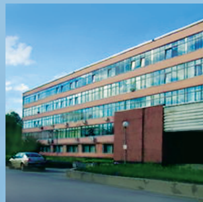
Здание ФКП «Пермский пороховой завод»
