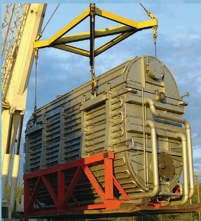
Конденсатор намораживания фталевого ангидрида
