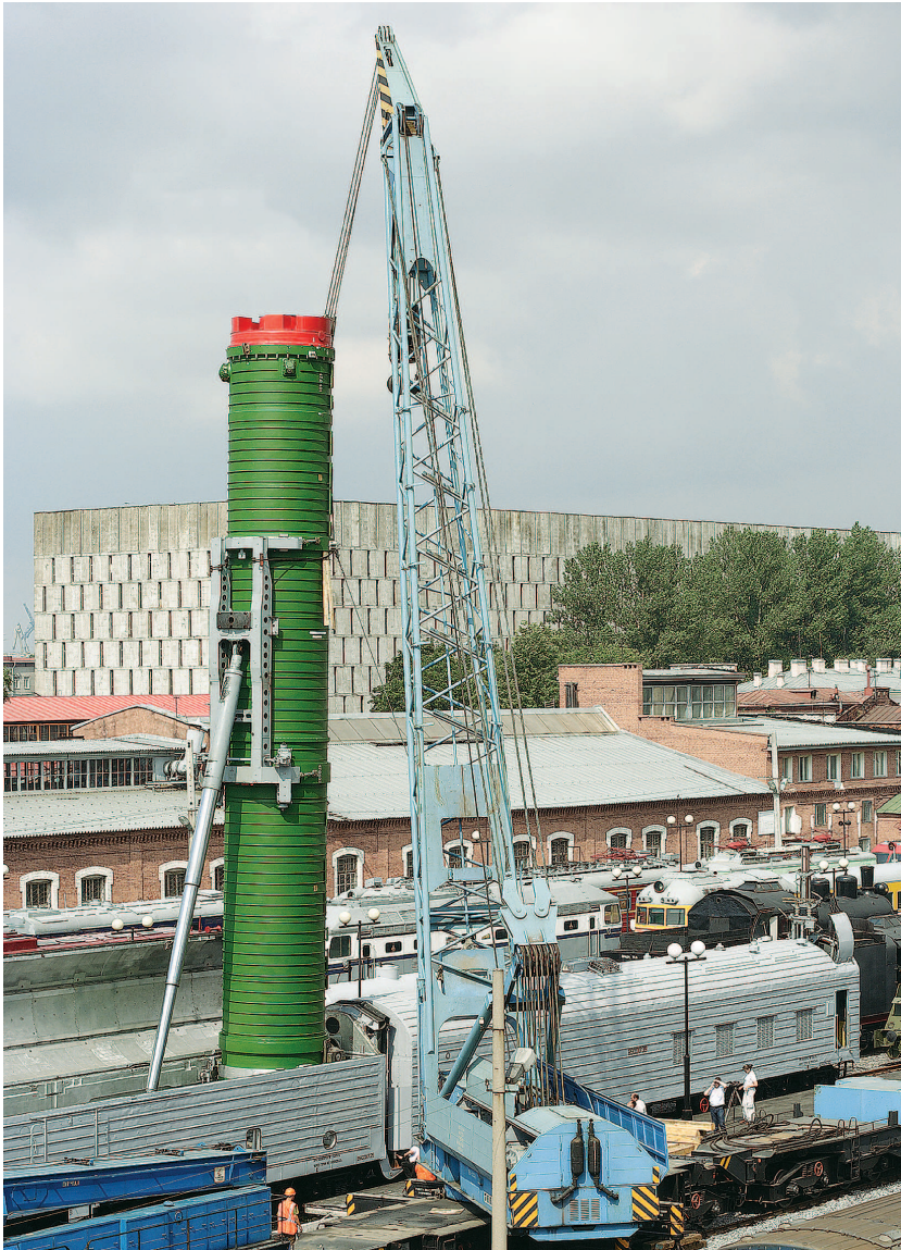
Установка транспортно-пускового контейнера
