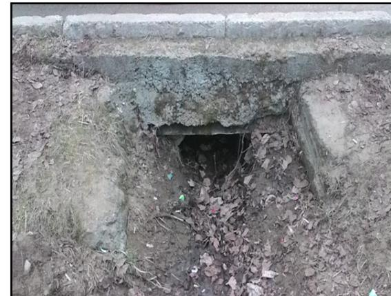
Рис.1. Выходной оголовок
